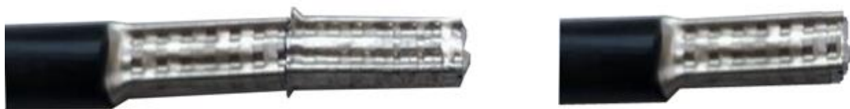
Рисунок 4.2 – Обжим провода СИП наконечниками НШВ для счетчика «Меркурий 238» (слева) и «Меркурий 208» (справа)
